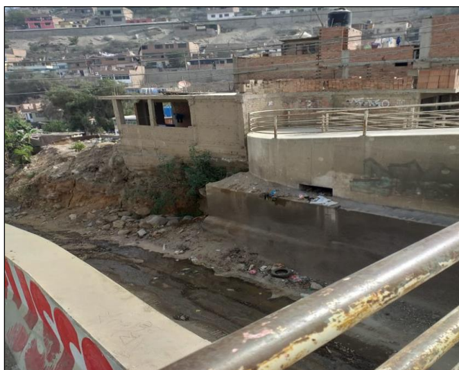
Fotografía 1: viviendas en riesgo
