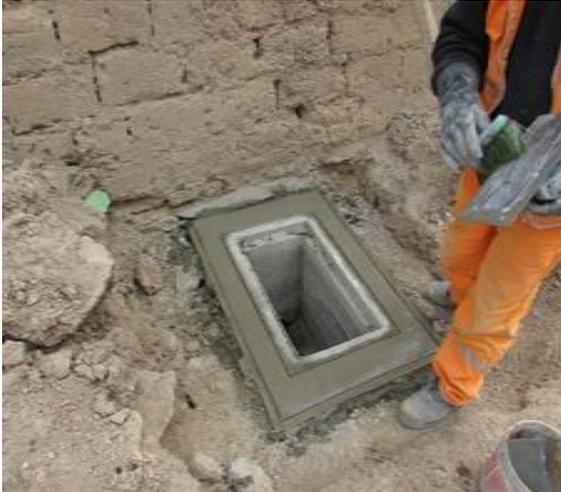
Para garantizar la durabilidad el marco y la tapa de la caja de registro deberán cumplir con la norma NTP 350.085: 1997, tener resistencia a la abrasión y corrosión, para lo cual el concreto tendrá como componente cemento Tipo V.
