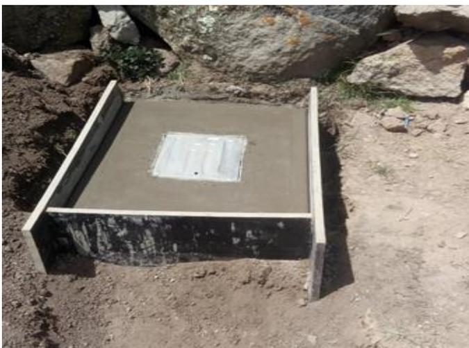
**Vereda:** cajuela de concreto para proteger la caja de medidor, toda caja de medidor o válvula tiene que tener tapa de lata galvanizada.
