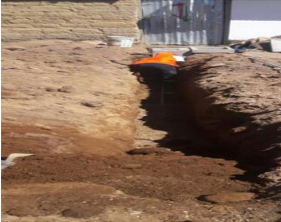
**Acometida:** la acometida es el recorrido de tubería desde el empalme de matriz hasta la caja de válvula o medidor, de acuerdo al requerimiento de proyecto los diámetros de tuberías varían, sin embargo, en este proyecto se concederá tuberías de 1”.
