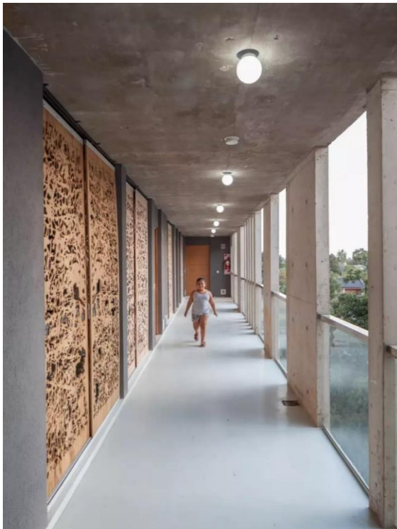
Figura: Edificio JCH (Argentina) – Pasillo, muro trabajo por un artista encofrado en madera, rememora los escritos de Borges. Fuente: Federico Kulekdjian
