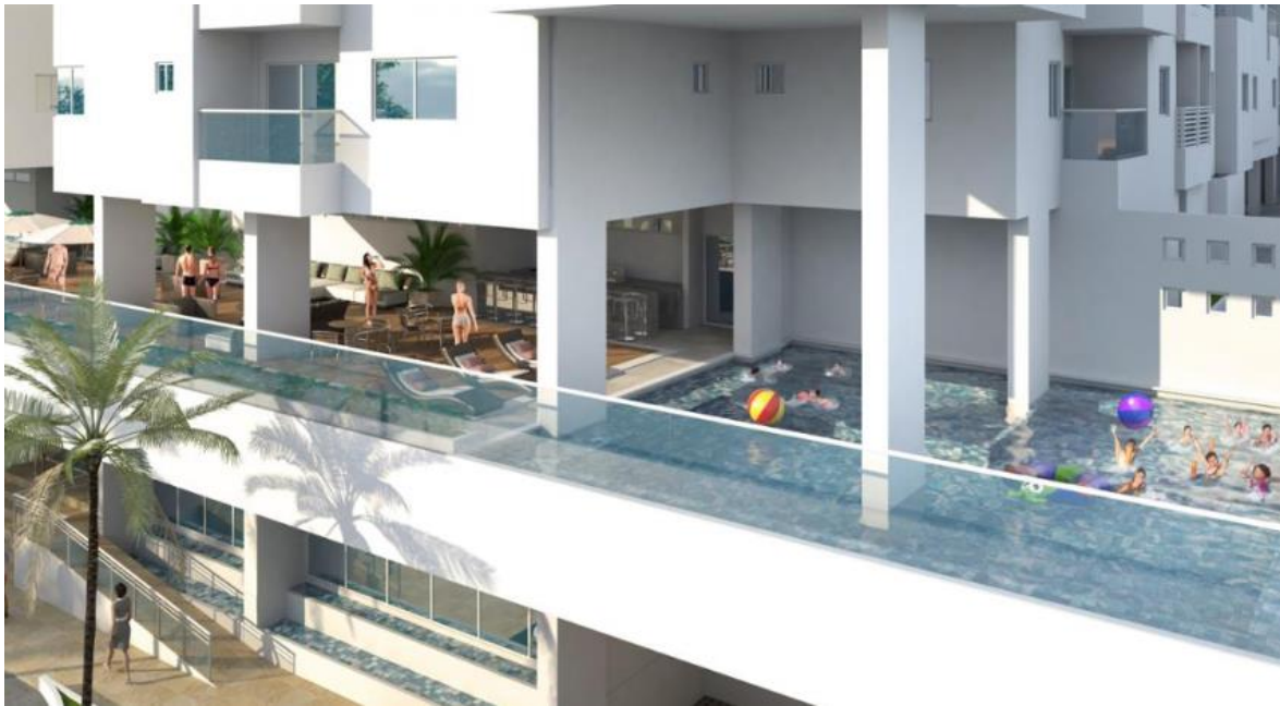
Figura: Conjunto Residencial Mirador de las Palmas (Colombia) – Zona de piscina Fuente: Boz Imbet Inmobiliaria
