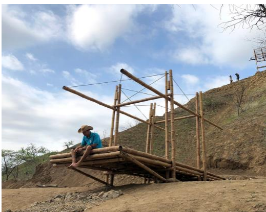
Figura: Observatorio de la poza de barro , Piura Fuente: Arch Daily Perú
