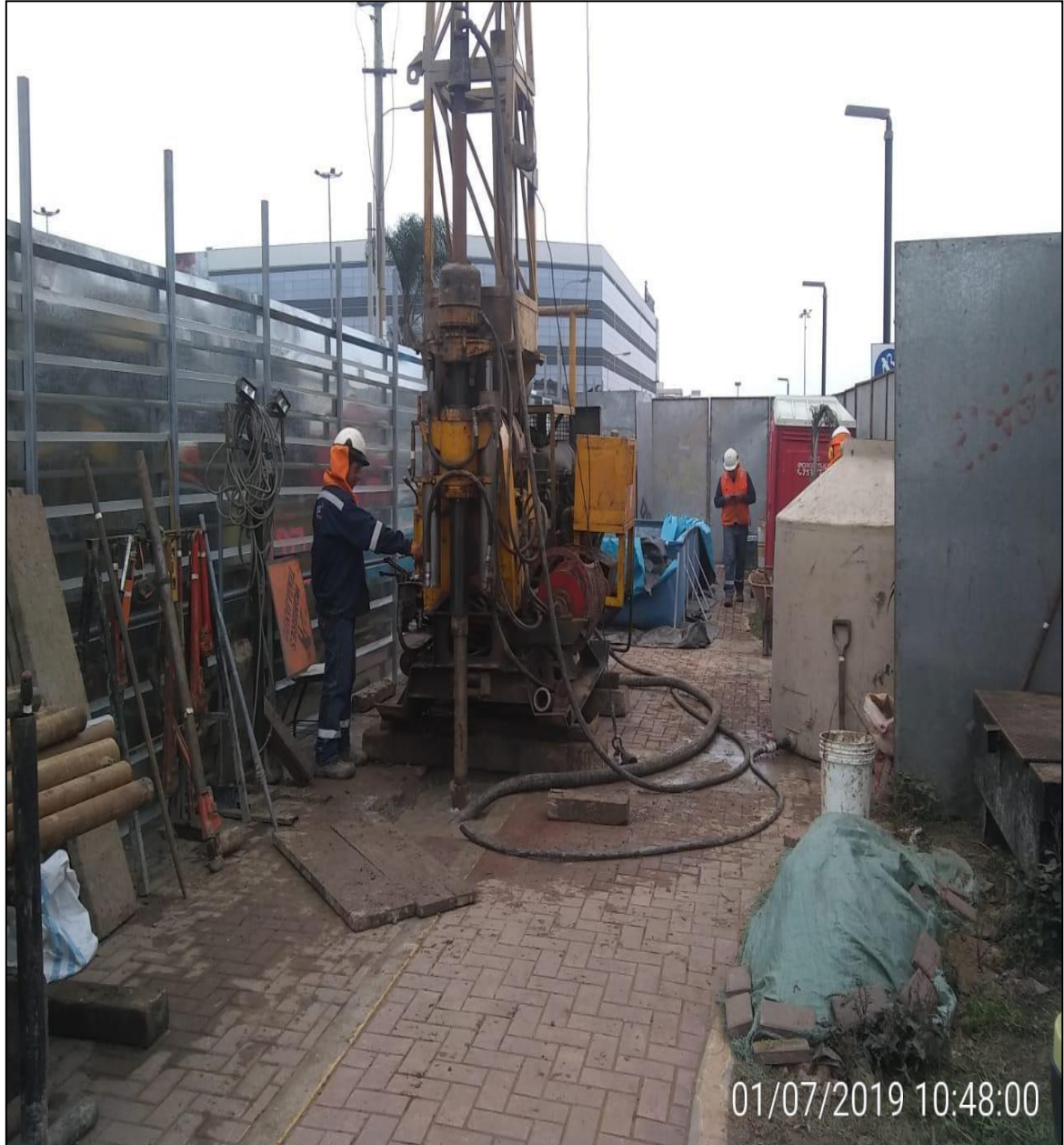
Figura 6: Perforación De Hitos
