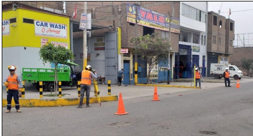
Figura 37: Inicio De Nivelación
