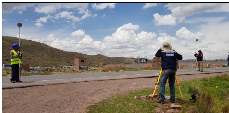
FOTO 11: LEVANTAMIENTO DE LA LINEA DE CONDUCCION
