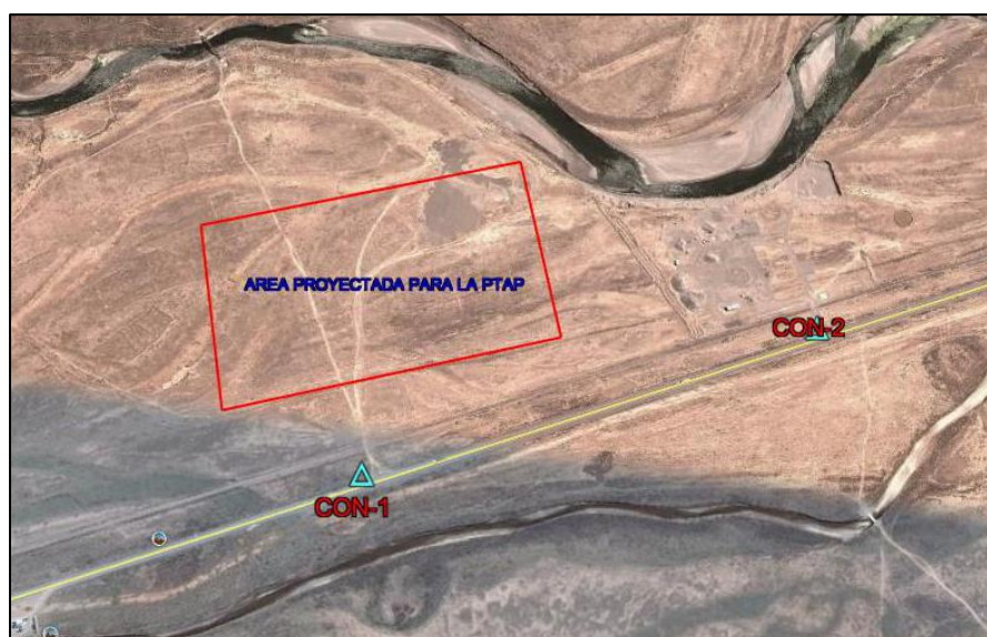
Figura 8: Zona proyectada para la construcción de la PTAP
