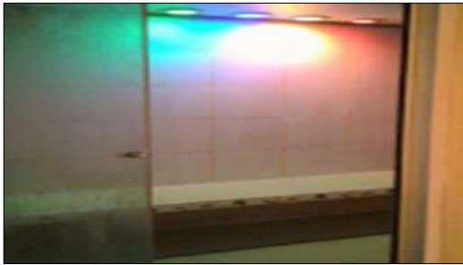
FIGURA 12: CUARTO DE LA SAUNA A VAPOR
