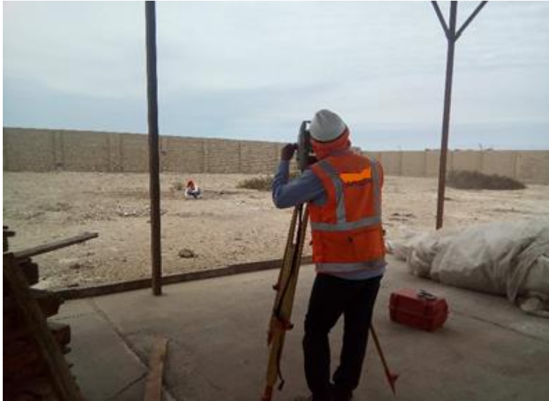
Fig. N° 19, Trazo y replanteo
