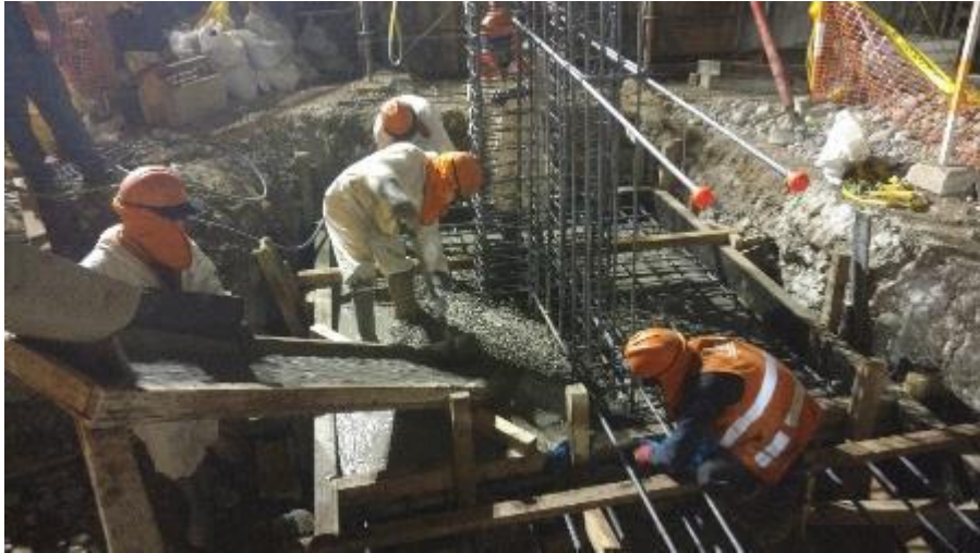
Fig. N° 24, vaciado de concreto
