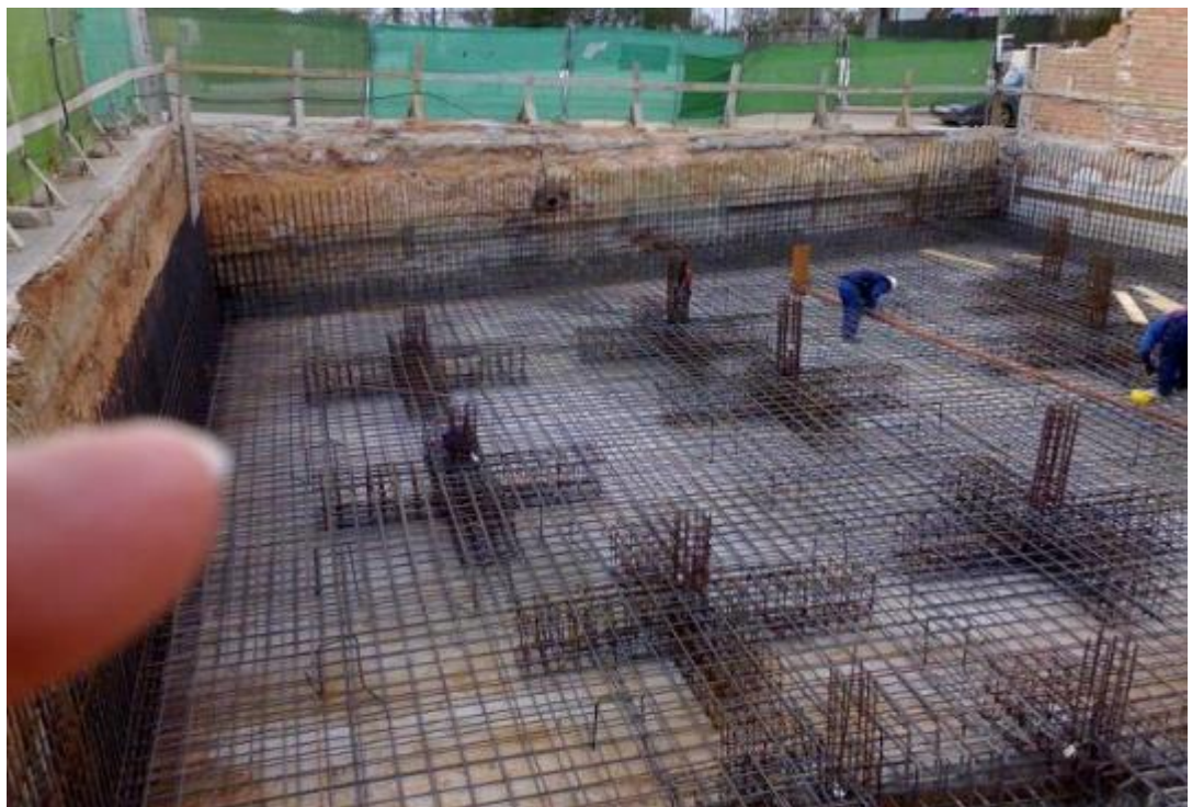
Fig. 09, refuerzo de acero en plateas de cimentación, fuente proyectos.habitissimo.es/proyecto/cimentacion-y-estructuras-edificio-viviendas
