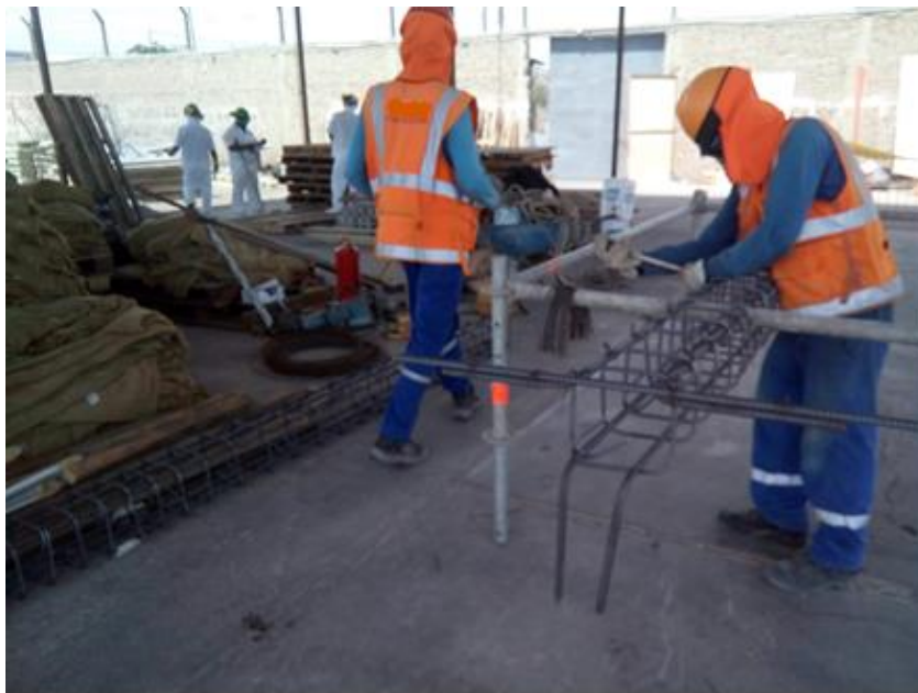
Fig. N° 20, armado de columnas
