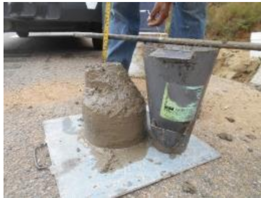
Toma de concreto realizados en situ.
