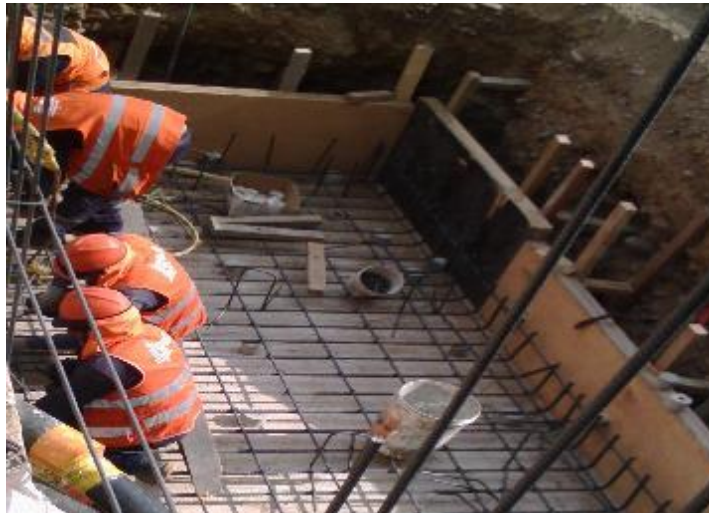
Fig. N° 21, colocación de acero en Situ
