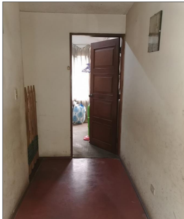
Figura 123 Vista hacia almacén (oficina)
