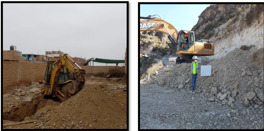
Fig. N° 8 – Realización de calicatas
